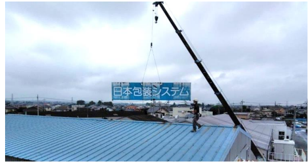
② 本社工場 旧事務所棟 屋上看板の撤去
