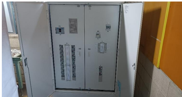
③ 本社工場 トレー工場 配電盤交換
