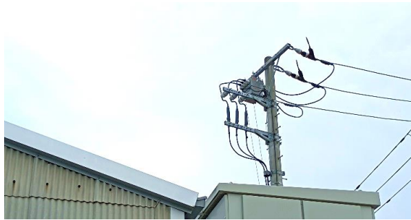
① 本社工場 高圧PASの交換
