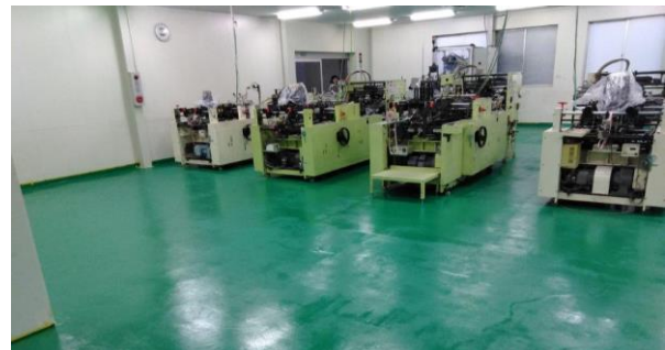
④ 本社工場 トレー工場 床面塗装
