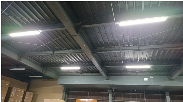
機械撤去と照明をLED化
